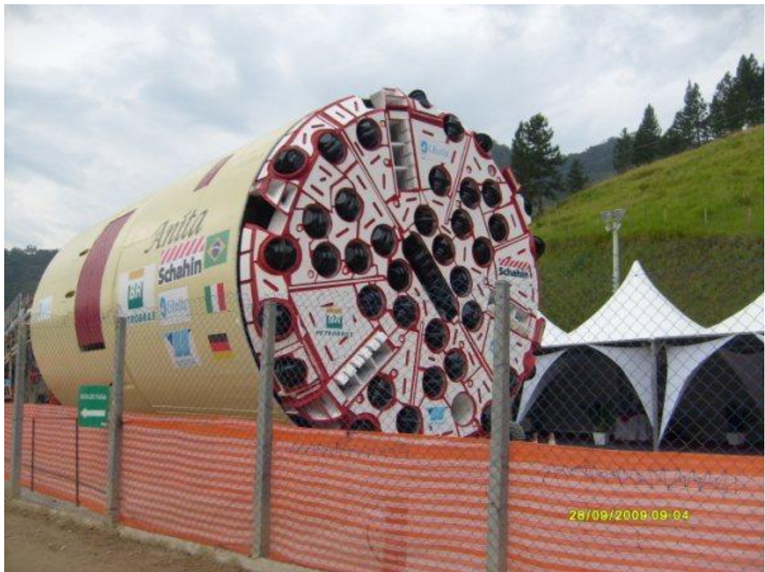
Figura 3: TBM para rocha dura no Brasil (fonte própria).
